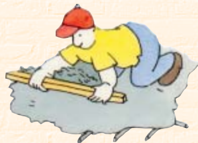
Sottofondi di pavimentazioni Malta M2
