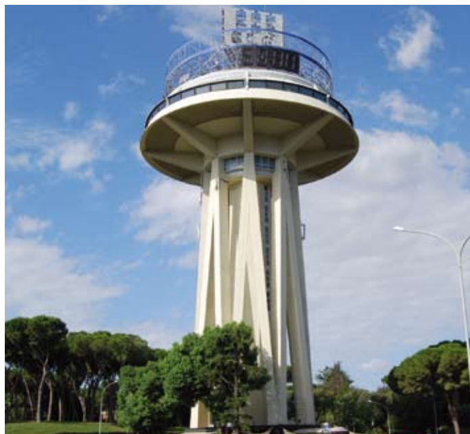
Il Fungo alla fine dei lavori. L'azione autopulente di TX Active® preserverà le superfici da possibili futuri annerimenti dovuti allo smog
