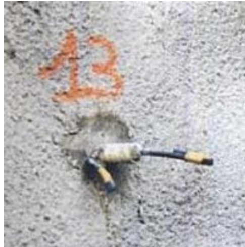
Fig. 2 - Dettaglio di armatura e relativa sigillatura
